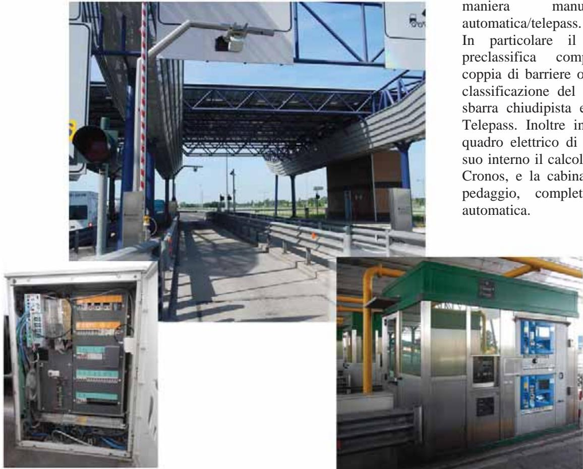
Fig.2 – Impianto di esazione pedaggio. In evidenza alcuni apparati che implementano le funzionalità richieste per il pagamento del pedaggio in maniera manuale e/o automatica/telepass.
